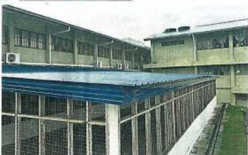
屋顶漏水的乒乓球室被翻新，让学生可以风雨无阻的练习和锻炼身体。
