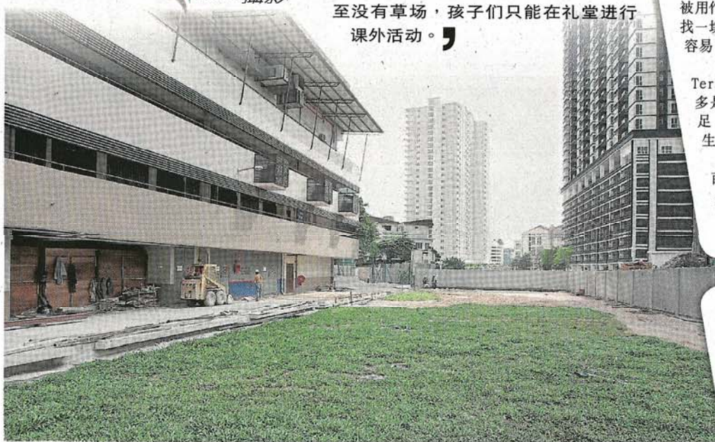
鋪上綠草 民义华小部分草场已铺上绿草，工程预计可在4月竣工。
